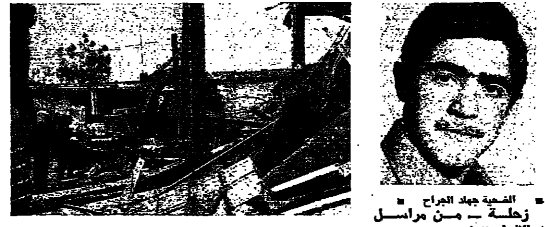
جانب من البناء الذي انهار
